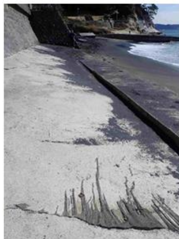
2023 年亀裂から砂が噴出。天面の陥没が顕著に。
