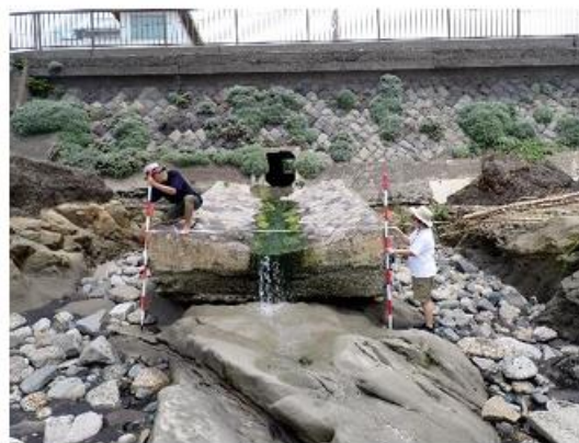
2023 年亀裂から砂が噴出。天面の陥没が顕著に。
