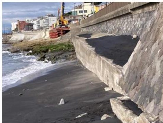
2024 年、階段の基礎が剥離して下降。翌年 1 月セメント袋で補修したが沈下が続いている。
