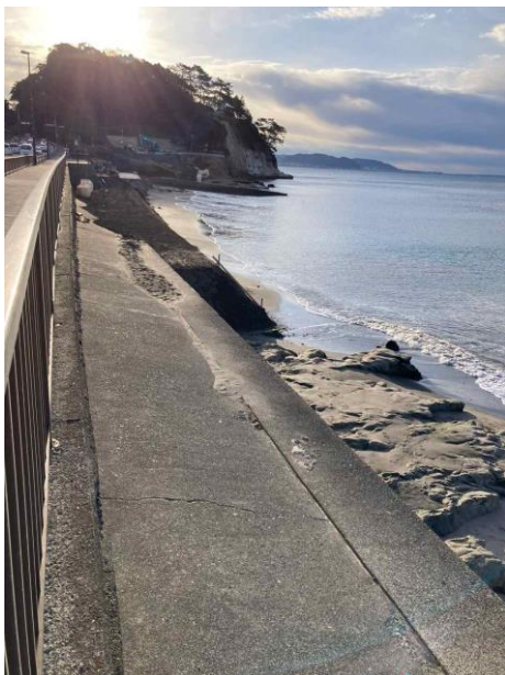
コンクリ壁に擦り付けた養浜材 3/7
