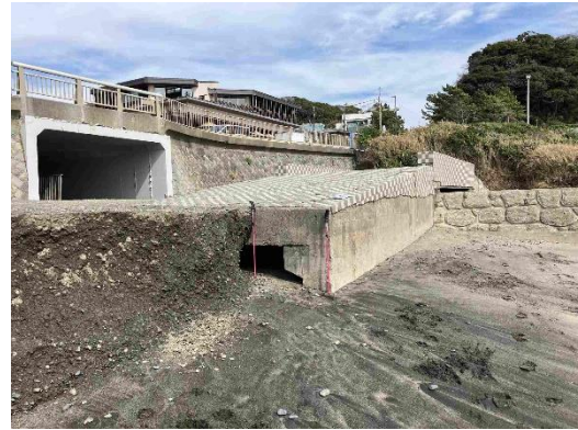
2025 年 3/12 極楽寺橋の西側。養浜工事完了後すぐに養浜材流出。橋桁の中が見えた 3/18
