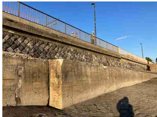
全て流出し壁が露出。壁の入角奥に流水確認。
