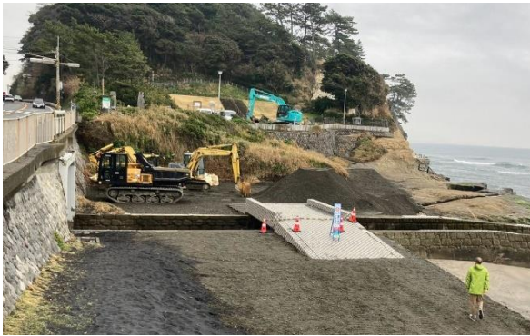
2025 年 3/12 極楽寺橋の西側。養浜工事完了後すぐに養浜材流出。橋桁の中が見えた 3/18
